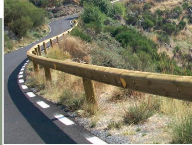
En su preocupación por ofrecer la máxima seguridad, Amatex ha diseñado dos barreras UBM, una para nivel de contención N2 y otra para nivel N1. Esto supone una novedad y el desarrollo de una solución específica para las vías de baja intensidad de tráfico, adaptada a sus características, y destierra la idea de que una barrera de nivel N2 es siempre mejor.
